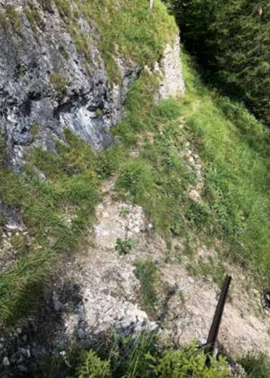
Paintlsteig, hier wäre eine Absicherung durch ein Drahtseil wünschenswert
